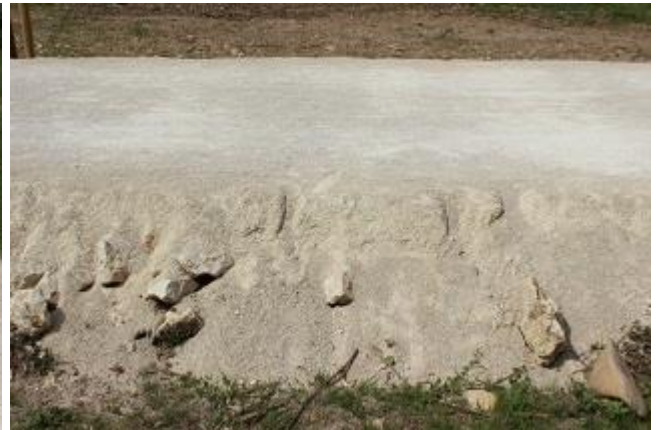
Tramo con capa de arena fina
